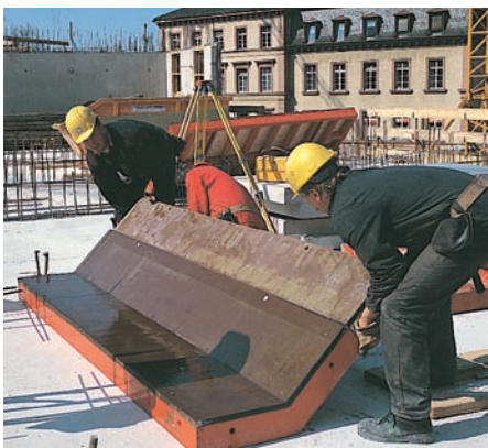
Γωνιακό πανέλο 135° με μεγάλα φύλλα μπετοφόρμ, σε κατασκευή ξενοδοχειακής μονάδας.
