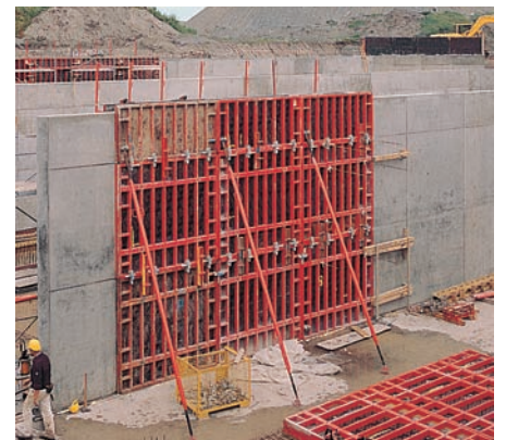
Πανέλα που χρησιμοποιούνται τοποθετημένα στο πλάι σε ύψος 6,0 m.
