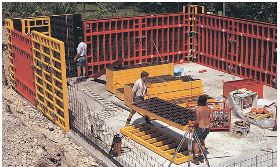
Εργοτάξιο με TRIO-L (αλουμίνιο) και χάλυβινο TRIO. Οι γωνίες και τα γεμίσματα καλυπώνονται με TRIO-L με τα χέρια και ο γερανός χρησιμοποιείται μόνο για τα μεγάλα χάλυβινα πανέλα (270 x 240).
