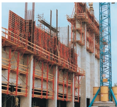
TRIO σε προβόλους αναρρίχησης
