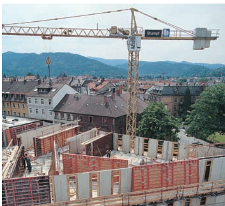
Πανέλα με πλάτος έως 9,00 m και ύψος 2,70 m, με μεγάλα φύλλα μπετοφόρμ.
