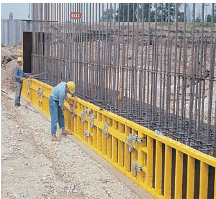
Χρήση του TRIO-L για καλούπωμα θεμελίων.
