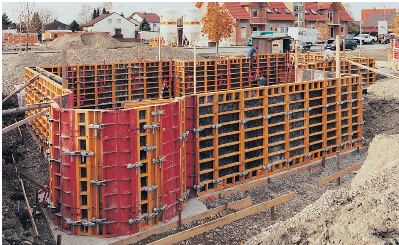
Το TRIO-L περιλαμβάνει 4 πλάτη πανέλων σε ύψη 270 και 90 cm.
