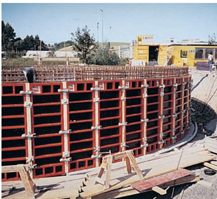
Τυποποιημένα πανέλα για κυκλικές κατασκευές.
