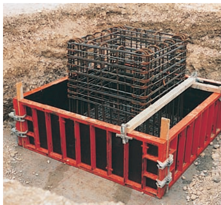
Πανέλα που χρησιμοποιούνται τοποθετημένα στο πλάι για θεμελίωση.
